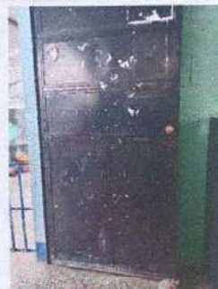
Foto2: Mantenimiento a puertas de metal
