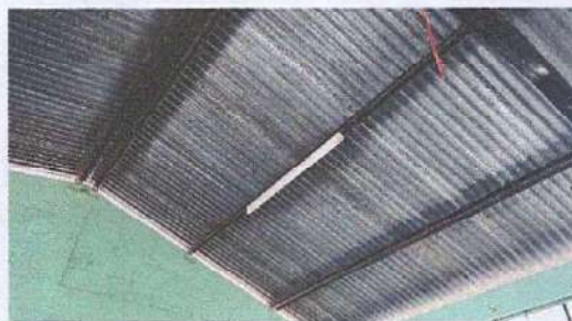
Foto2: Sustitución de lámparas sin funcionamiento en aula y corredor
