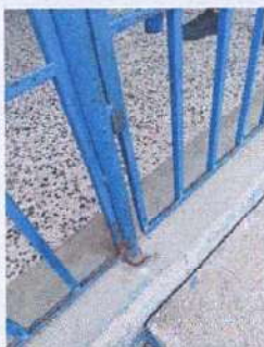
Foto1: Sustitucion de baranda de corredor
