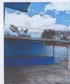
Foto 4: Cambio de techo de esenario
